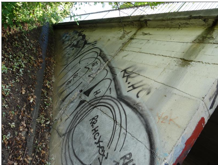
8.JPG Pravé křídlo Op1. Smáčení z pod římsy, lokální opad omítky.
