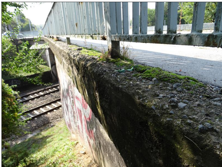
22.JPG Římsa - degradace betonu, vegetace.
