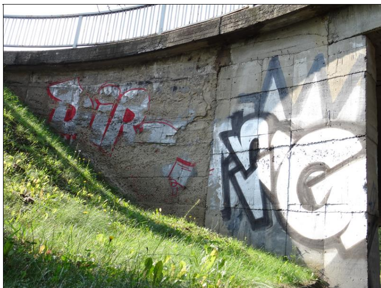
11.JPG Levé křídlo Op2. Průsak vody, degradece betonu, koroze výztuže, opad omítky.
