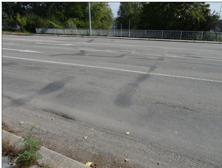
19.JPG Deformace vozovky - vyjeté koleje, trhliny.
