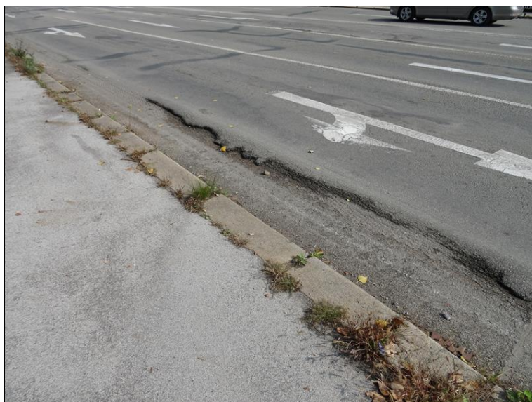
20.JPG Deformace krytu vozovky v místě vyjeté koleje u pravostranného chodníku. Uchycená vegetace ve spárách chodník. obrub.
