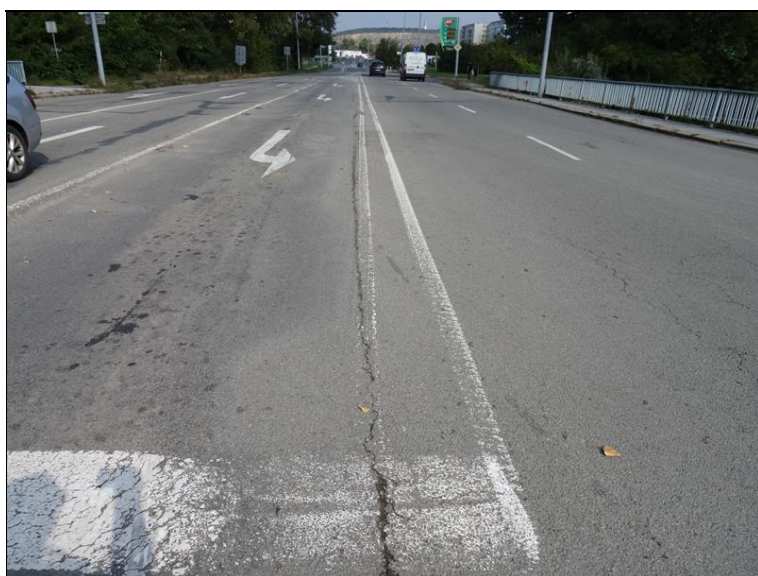
21.JPG V krytu vozovky podélné i rozvětvené trhliny . Uprostřed podélná široká trhlina resp. studená spára.
