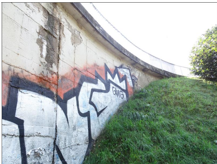
14.JPG Pravé křídlo Op2. Smáčení z pod římsy, lokální degradace betonu.
