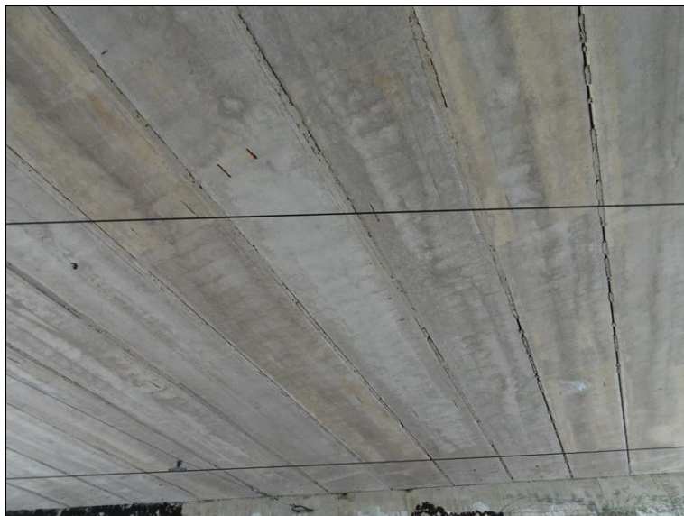
16.JPG Podhled středové části NK ve směru k Op1. Stopy průsaků spárami mezi nosníky. Opadlá malta ze spár mezi nosníky, lokálně obnažená korodující výztuž.
