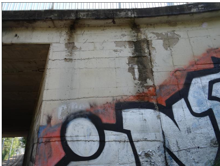
13.JPG Horní část pravého boku Op2. Průsak vody z pod římsy, v místě zátoků degradace betonu.
