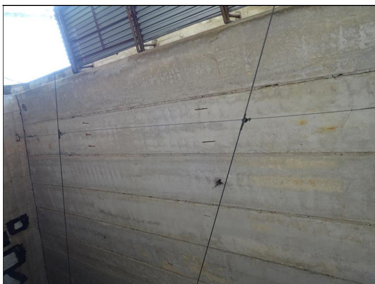
15.JPG Podhled nosné konstrukce (NK) zleva směrem k Op2. Vápenné výluhy, lokálně obnažená korodující výztuž, opad malty ze spár.
