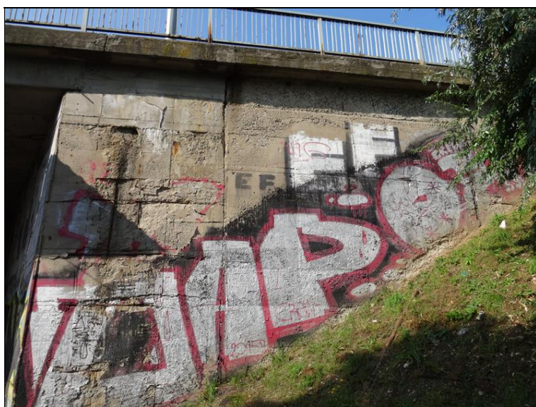
6.JPG Levé křídlo Op1. průsak vody pod úložným prahem, degradace betonu, koroze výztuže, opad omítky.
