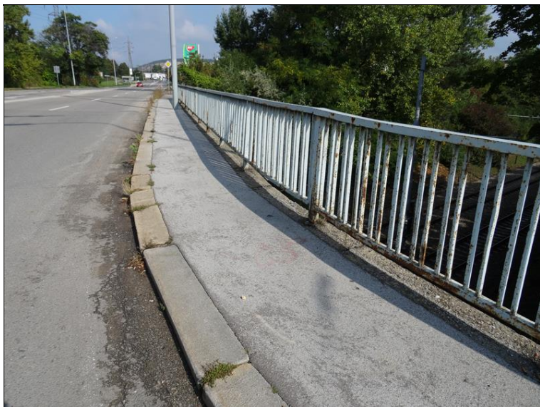
23.JPG Koroze levého zábradlí.
