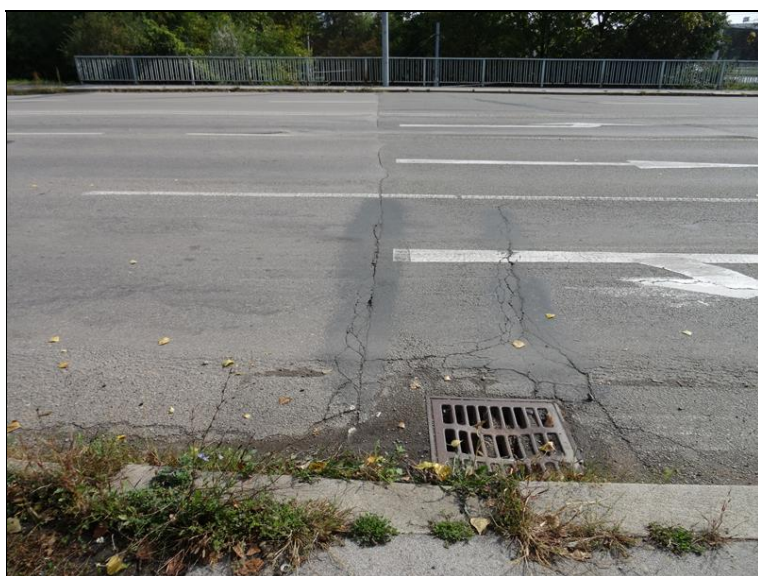
18.JPG Vozovka na začátku mostu. Silná deformace vozovky, trhliny, vegetace.
